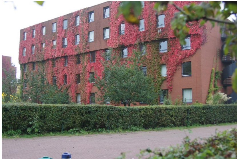
GWL Terrain. Photo courtesy of GWL Terrain.
