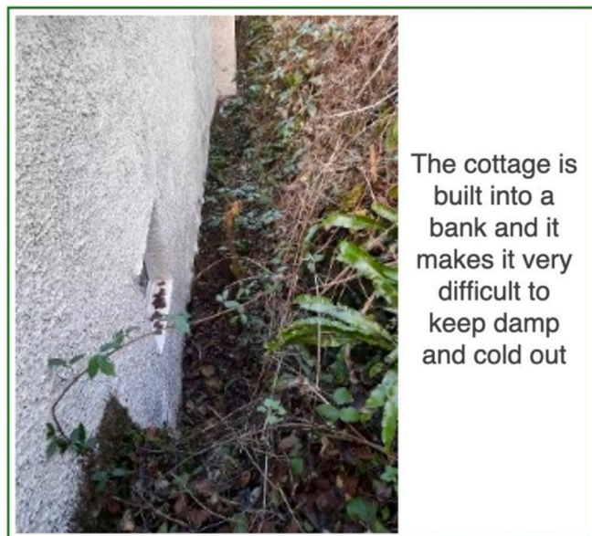
Fig. 3. I1 PE of the rear wall damp challenges.
