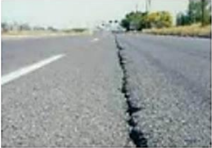
Longitudinal Cracking
